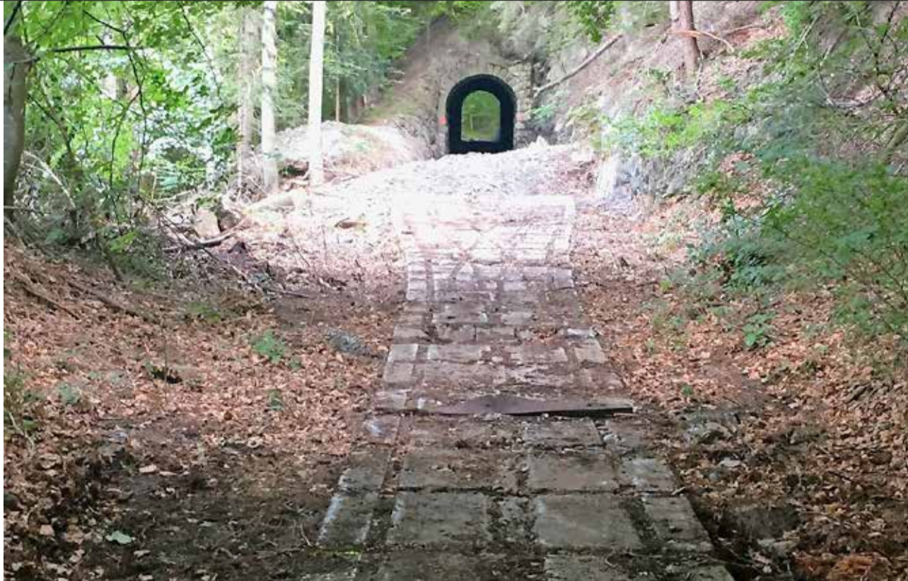
Schwerarbeit der Taminaforst: Das Bahntrasse zeigt sich von umgestürzten Bäumen und teilweise meterhohen Erdmassen befreit.
